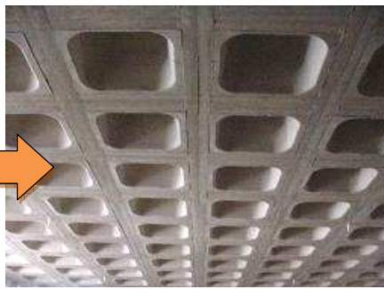
Εικόνες 15,16,17: Οι πλαστικότυποι μπορούν να συνδυναστούν με κατάλληλες τάβλες ή κομμάτια για να δώσουν την επιθυμητή διαδοκίδα.
