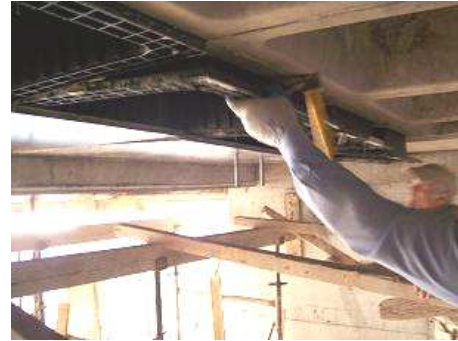
Εικόνα 40: Το σκεπάρνι πρέπει να χρησιμοποιείται στο μέσον του φτερού και όχι στη γωνία.
