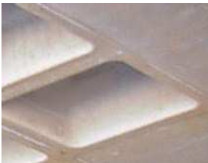
Εικόνα 21: Πρώτος τρόπος – πλαστικότυπος περασιά με το πέτσωμα της συμπαγούς ζώνης.
