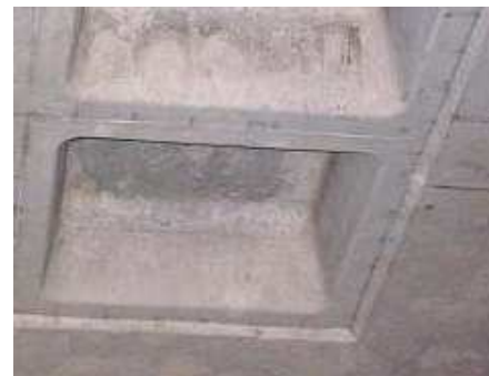
Εικόνα 22: Δεύτερος τρόπος – πλαστικότυπος πάνω στο πέτσωμα της συμπαγούς ζώνης με φαλτσογωνιά στην περίμετρο της.
