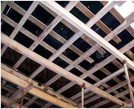
Εικόνες 8,9: Πολλαπλές δυνατότητες «πετσώματος» για την τοποθέτηση των πλαστικοτύπων.
