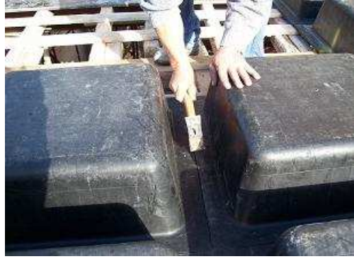
Εικόνα 23: Οι πλαστικότυποι καρφώνονται τουλάχιστον στα μέσα των φτερών τους.
