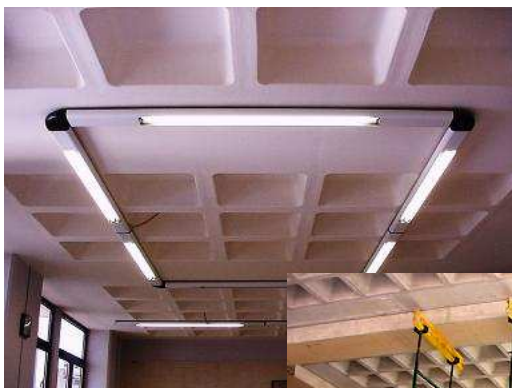
Εικόνες 11,12: Η συνέχεια των διαδοκίδων εξασφαλίζει καλαίσθητη οροφή – η ασυνέχεια (πάνω φωτογραφία) δεν δίνει αρμονική εικόνα.
