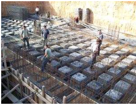
Εικόνες 28,29: Οι πλαστικότυποι δημιουργούν ένα σταθερό και άνετο δάπεδο εργασίας.
