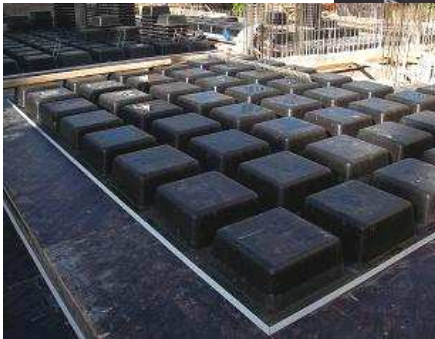
Εικόνες 18,19,20: Λεπτομέρειες στο όριο φατνωματικής περιοχής - συμπαγούς ζώνης.
