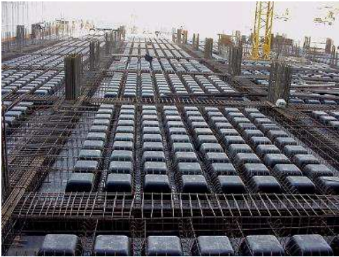
Εικόνα 13: Οι διαδοκίδες πρέπει να είναι συνεχείς στα διαδοχικά φατνώματα.
