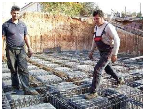
Εικόνες 28,29: Οι πλαστικότυποι δημιουργούν ένα σταθερό και άνετο δάπεδο εργασίας.
