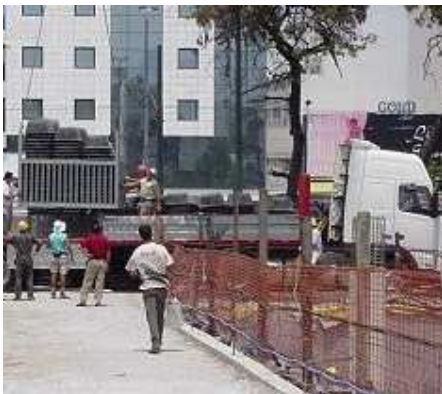
Εικόνα 41: Φόρτωση των πλαστικότυπων στο εργοτάξιο με κιβώτιο γερανού.
