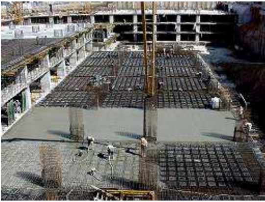
Εικόνα 36: Οι πλαστικότυποι εξασφαλίζουν σωστή και άνετη διάστρωση σκυροδέματος.
