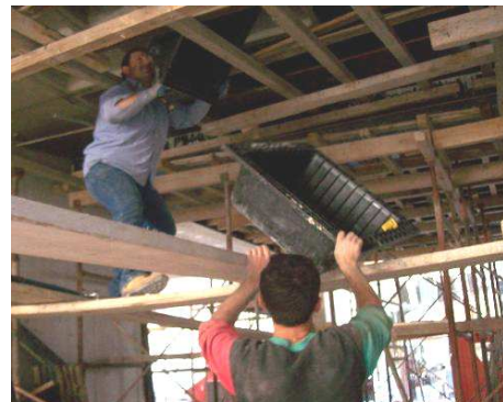
Εικόνα 38: Το ξεκαλούπωμα γίνεται εύκολα και σωστά με ζευγάρι εργατών.
