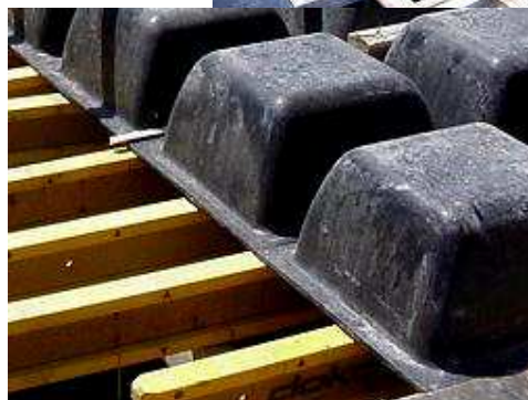
Εικόνες 6,7: Οι πλαστικότυποι δεν απαιτούν πλήρες ή "σφιχτό" πέτσωμα.
