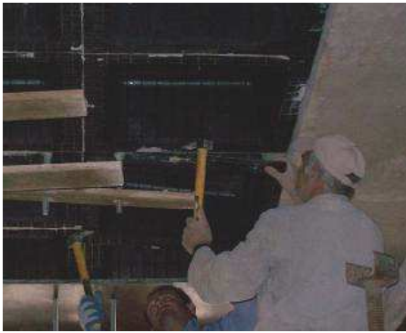
Εικόνα 39: Το ξεκαλούπωμα ξεκινάει από έναν ακραίο πλαστικότυπο του φατνώματος.
