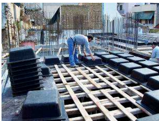
Εικόνα 3: Στο εργοτάξιο οι πλαστικότυποι μπορούν να τοποθετούνται προσωρινά σε πετσωμένο κομμάτι του ξυλότυπου.
