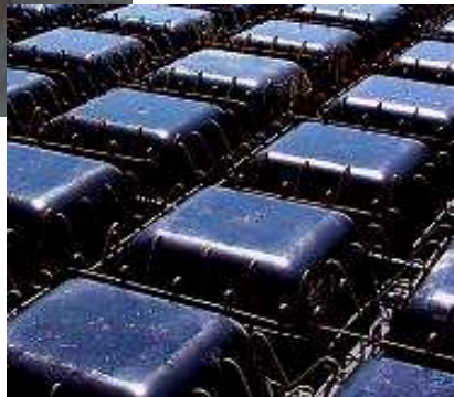
Εικόνες 30,31: Οι πλαστικότυποι συνδυάζονται με πρισματικά τσέρκια στη μορφή των διαδοκίδων.
