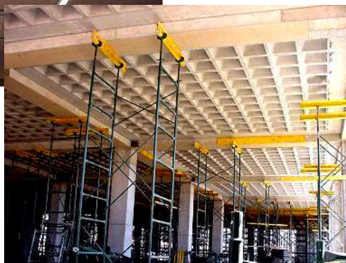
Εικόνες 11,12: Η συνέχεια των διαδοκίδων εξασφαλίζει καλαίσθητη οροφή – η ασυνέχεια (πάνω φωτογραφία) δεν δίνει αρμονική εικόνα.
