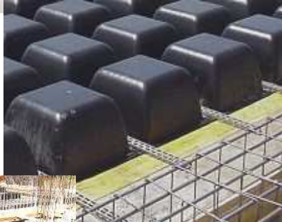
Εικόνες 18,19,20: Λεπτομέρειες στο όριο φατνωματικής περιοχής - συμπαγούς ζώνης.
