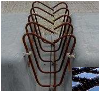
Εικόνες 30,31: Οι πλαστικότυποι συνδυάζονται με πρισματικά τσέρκια στη μορφή των διαδοκίδων.
