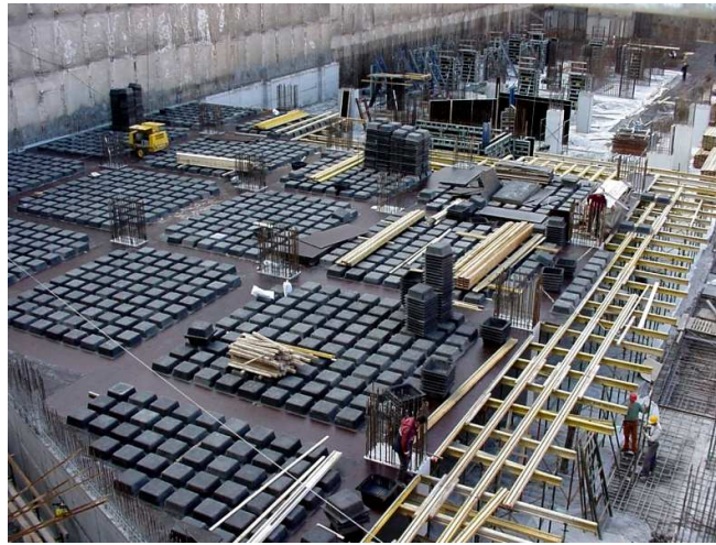
Εικόνες 8,9: Πολλαπλές δυνατότητες «πετσώματος» για την τοποθέτηση των πλαστικοτύπων.
