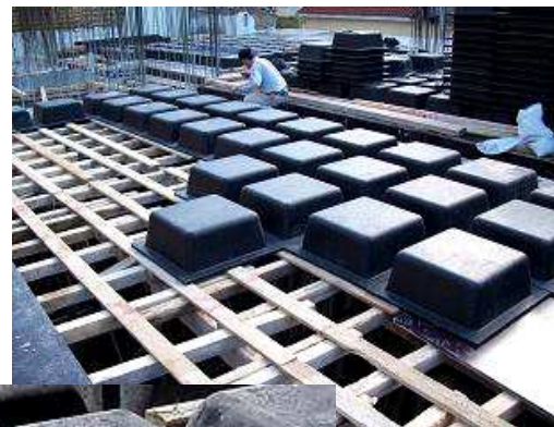
Εικόνες 6,7: Οι πλαστικότυποι δεν απαιτούν πλήρες ή "σφιχτό" πέτσωμα.
